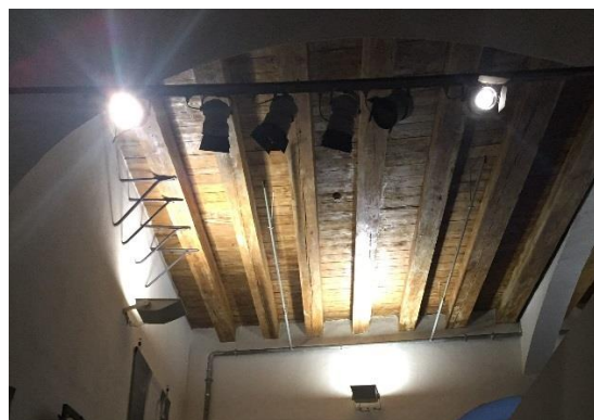
Figura 4.12 - Particolare dei corpi illuminanti ubicati all'interno dell'edificio.
